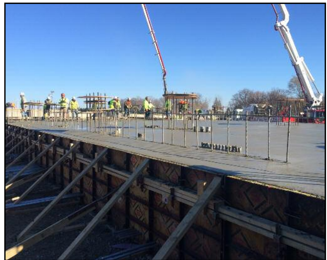
Poured mill mat slab
